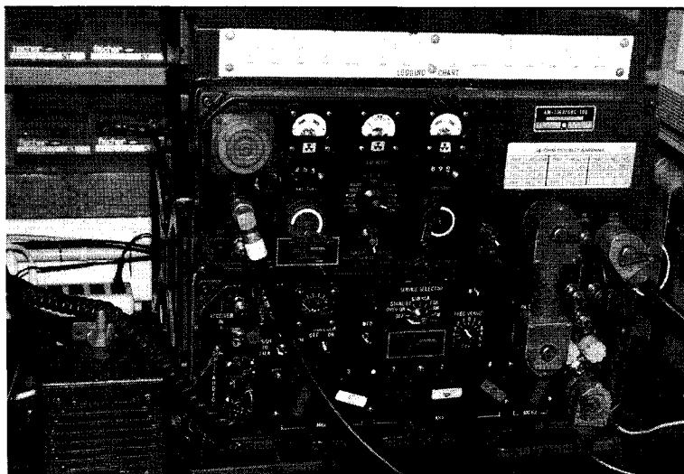
Foto 1 - La stazione 106 completa: si noti l'eccitatore RT-834/GRC (sotto) e l'amplificatore lineare - accordatore d'antenna AM-3349 (sopra).
